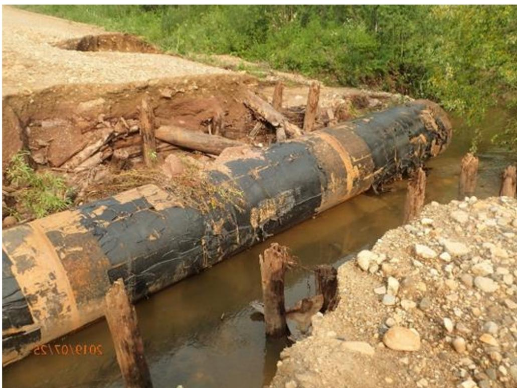
Рис 4.5. Размытый мостовой переход после июльского паводка 2019 г. на грунтовой лесовозной дороге в Усть-Куломском районе.
