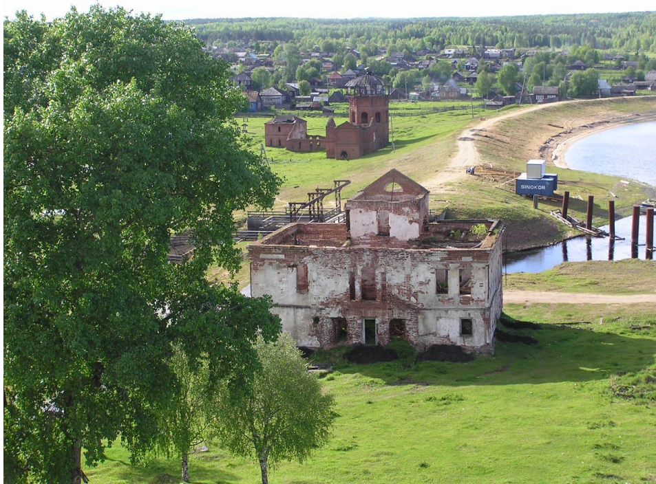
Рисунок 4.1. – Общий вид на завод, западный вал плотины и заводоуправление
