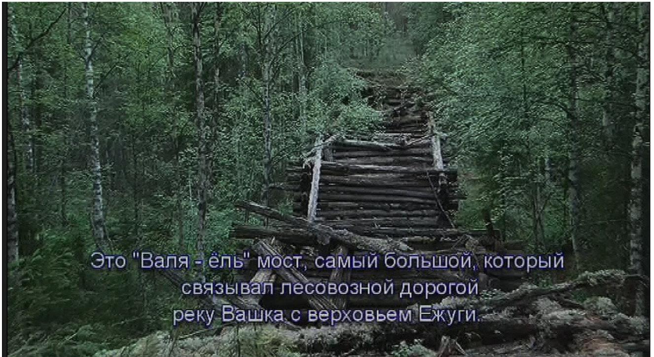
Рисунок 31. Разрушенный мост через ручей Валя-ель на левом берегу р. Зырянская Ежуга
